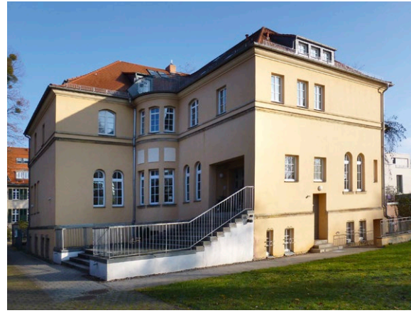
31 – Wiener Straße 86, Gartenfassade, 2020 Blick nach Nordosten
