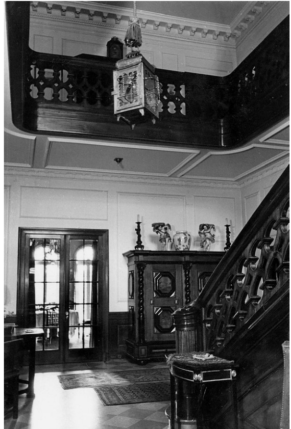
25 – Tiergartenstraße 64, Treppenhaus, vor April 1938 Blick nach Südwesten
