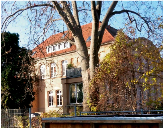
30 – Wiener Straße 86, 2020 Blick nach Westen
