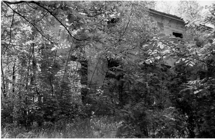
12 – Tiergartenstraße 64, Eingangsfassade, Mai 1962 Blick nach Westen
