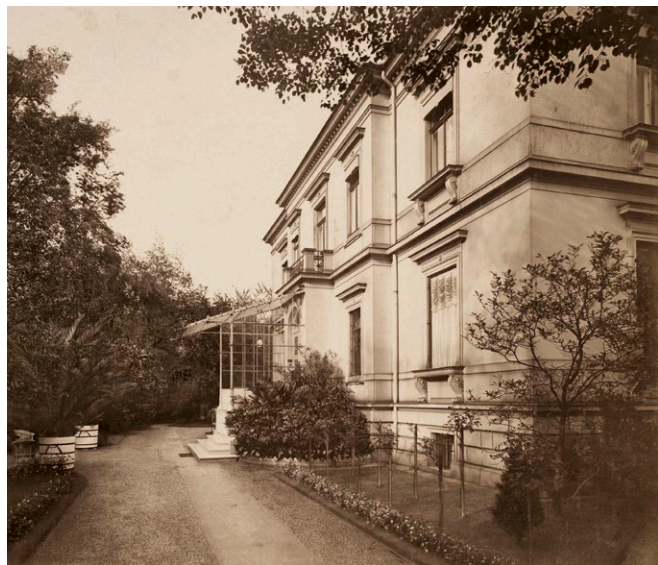
3 – Wiener Straße 25, Eingangsfassade, vor 1933 Blick nach Nordosten
