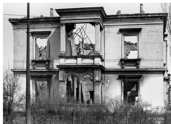
9 – Wiener Straße 25, April 1952 Südwest-Fassade
