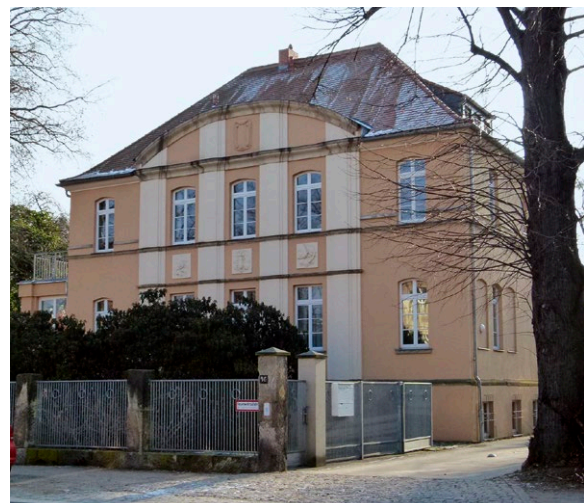
29 – Wiener Straße 86, Straßenfassade, 2012 Blick nach Süden
