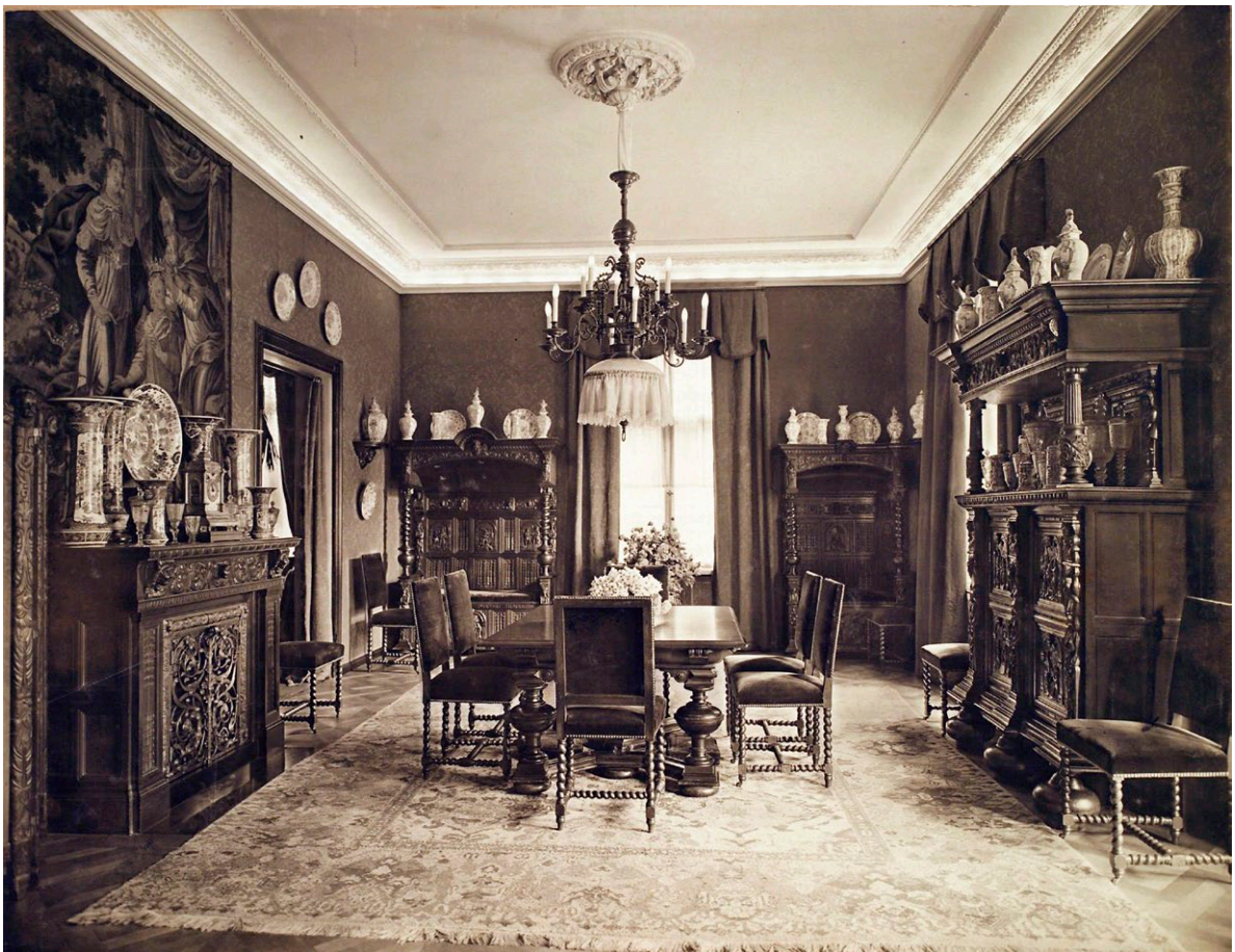
6 – Wiener Straße 25, vor 1933 Blick in das Esszimmer
