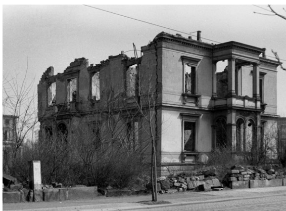
8 – Wiener Straße 25, April 1952 Blick nach Nordosten
