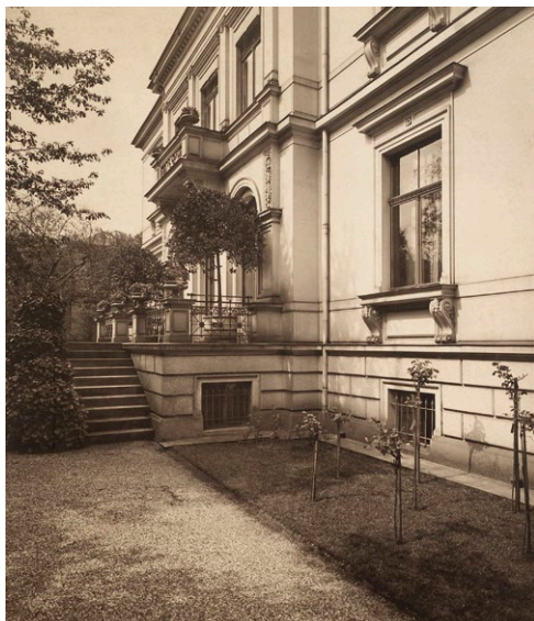
2 – Wiener Straße 25, Gartenfassade, vor 1933 Blick nach Südosten
