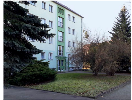
13 – Wohnblock, Eingang Tiergartenstraße 66 (ehemals Tiergartenstraße 64), 2020 Blick nach Westen
